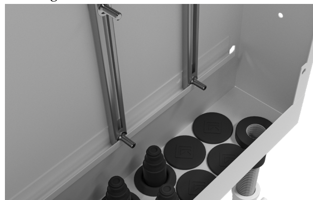
Montera rör genomföringar och tätningssluggar.
